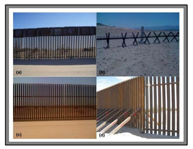
Figure 16. Border Fence Designs: (a) PV-1, (b) VF-2, (c) P-2, (d) PV-4
